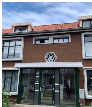
Foto 12: Nieuwe entrees en gevelrenovatie Rederijkerstraat
