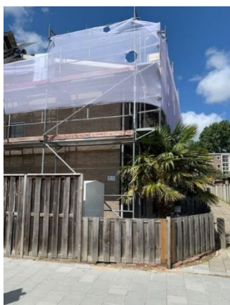
Foto 9: Zonnepanelen plaatsen op daken Drapeniersgaarde
